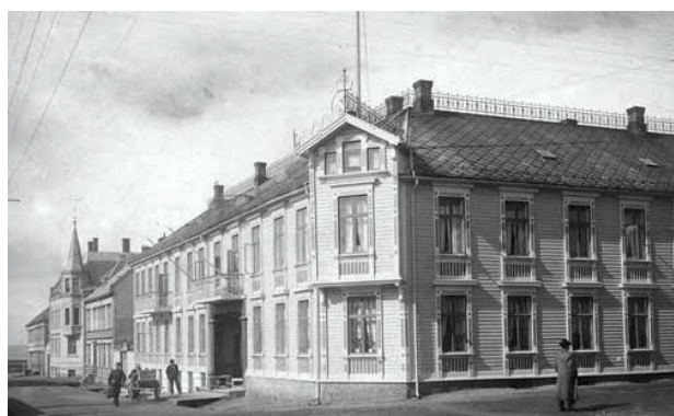
Slik såg det ut Langli Hotell som vart bygd opp i 1902 etter bybrannen i 1900. Dette hotellet vart kjøpt av Bondeheimen og Inntrondelag Ungdomssamlag i 1902 og skifta da namn til Grand hotell. Brann ned saman med resten av byen ved tyskarane si bombing 21. april 1940. Bygd opp igjen av Bondeheimen/IU etter krigen. Ca 1985 vart det selt til Thilertfamilien v/Bjørn Thilert. IU dreiv altså hotellet i ca 65 år av desse hundre åra.
